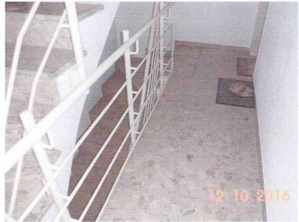
Treppenhaus - Haus-Nr. 33 - 1. OG
