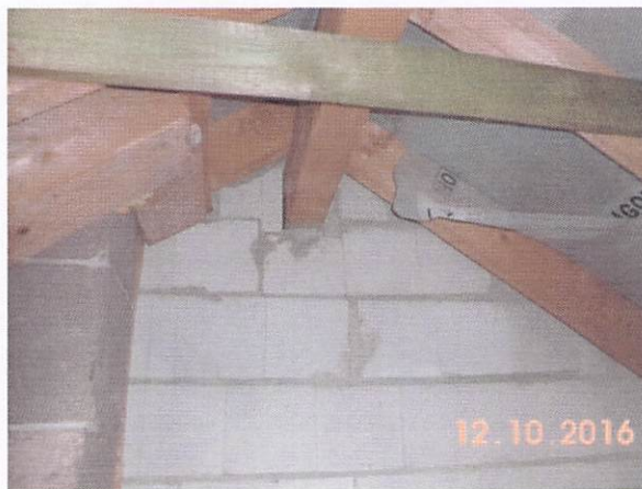
Firstpfette auf Kalksandsteinmauerwerk im DG 35
