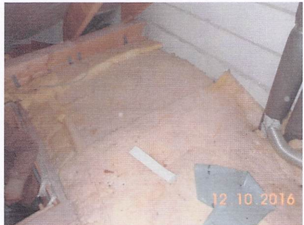
Teilbefestigung im Dachraum - Haus-Nr. 35
