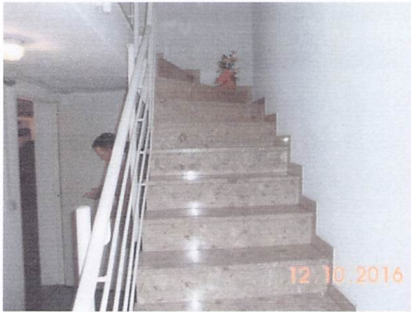
Treppenhaus - Haus-Nr. 33 - KG
