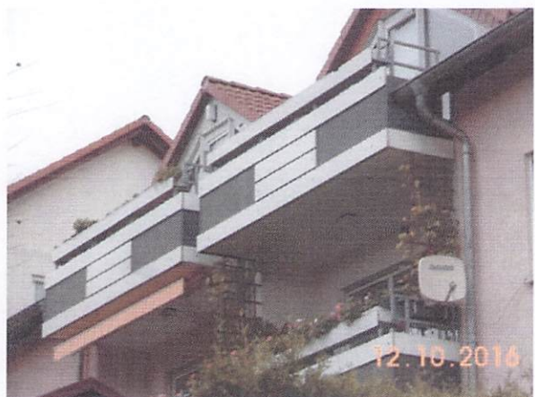
Balkonanlagen im 1. OG und DG
