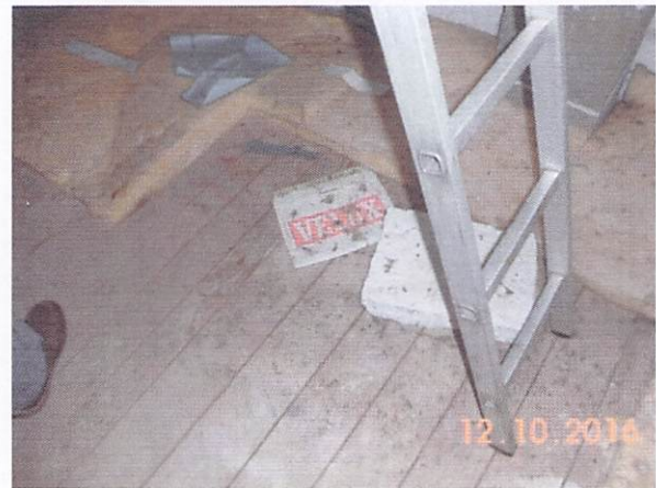
Teilbefestigung im Dachraum - Haus-Nr. 35
